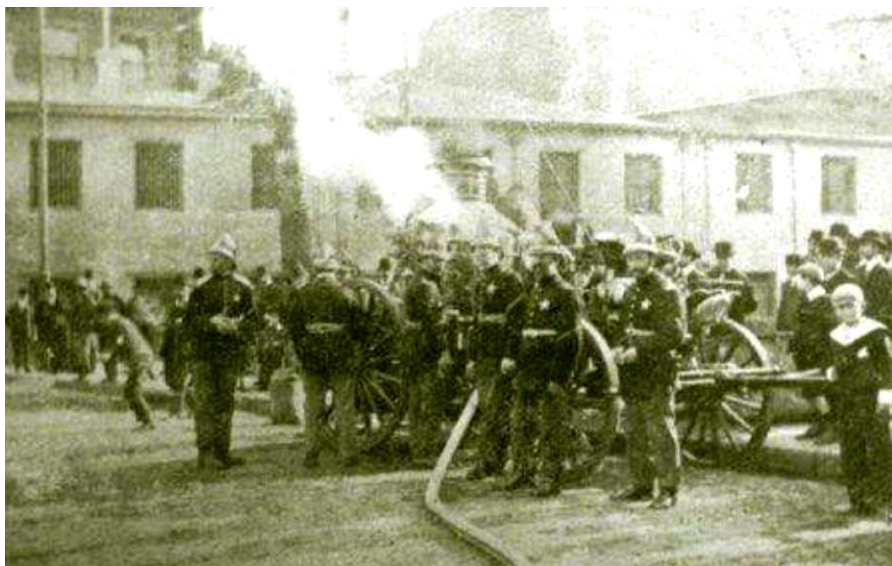
Bomba La Cucha, en operaciones, Valparaíso, c. 1910. Fuente 3° Cia. de Valparaíso.
